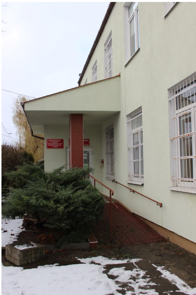
Wejście główne z podjazdem dla osób z niepełnosprawnościami poruszających się na wózkach.
